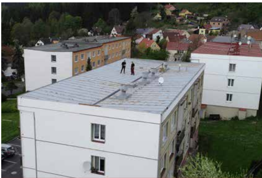
Obr. 3 Pohľad na dvojplášťovú strechu s plechovou krytinou
