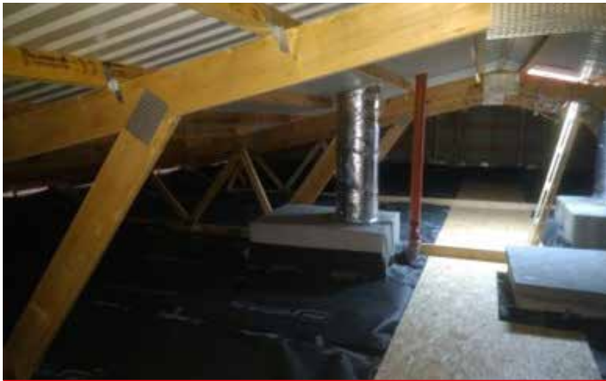
Obr. 6 Pohľad do nového podkrovného priestoru (priestor je úplne prístupný, vetraný a vybavený pochôdnou lavičkou, aby sa nepoškodila izolácia)
