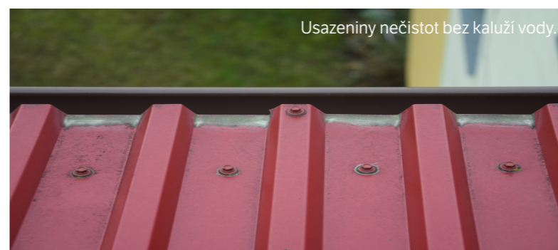
Nečistota a kaluže vody vzniklé díky chybějícímu ohnutí.
