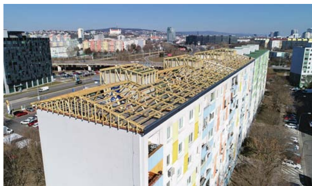
Dřevěná nosná konstrukce
