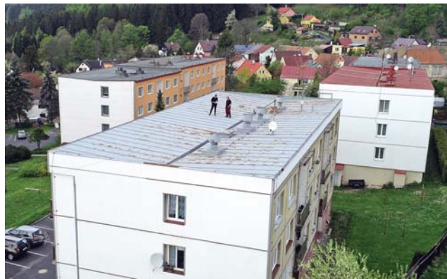
Oprava vytvořením nové ploché střechy nad stávající
